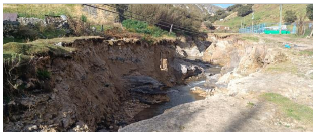
FOTO N° 03: Vista de un tramo de río con una erosión considerable de la margen, formando un talud vertical inestable que compromete la infraestructura adyacente (caminos o construcciones).
